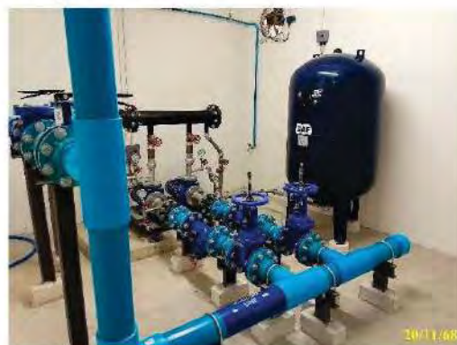
ถังสำรองน้ำชั้นตาดฟ้า พร้อมเครื่องปั้มน้ำชั้นตาดฟ้า
