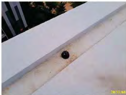
ระบบระบายน้ำจากหลังคา
