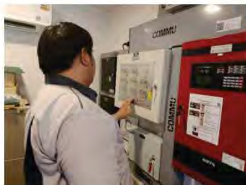
ภาพช่างตรวจเช็คอุปกรณ์ป้องกันและเตือนอัคคีภัย
