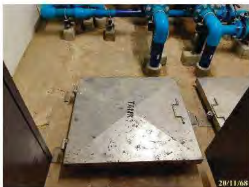
ถังสำรองน้ำใต้ดิน พร้อมเครื่องสูบน้ำใต้ดิน
