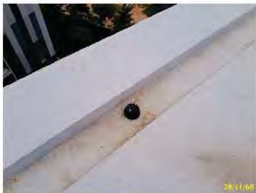
ระบบระบายน้ำฝนจากหลังคา
